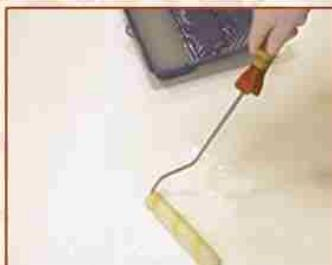
2. Нанесите клей на обратную сторону фрески при помощи малярного валика и накройте ее поверхность полиэтиленовой пленкой.
