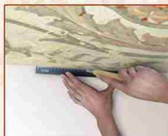
7. Края полотна обрежьте острым ножом по линейке или шпателю.
