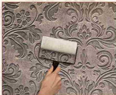
3. Складки и пузыри разгладьте валиком для обоев или обойным шпателем.
