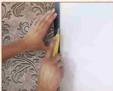
4. Край полотна подрежьте острым ножом по линейке или шпателю.
