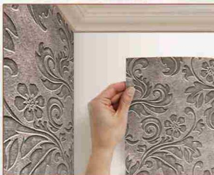
5. Панностыкуются строго в углах между стенами без нахлеста, стык в стык.
