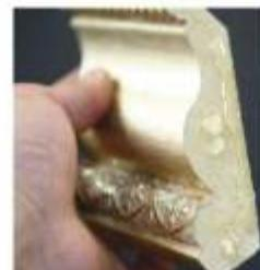
После этого выполнить монтаж декоративного элемента на клей, предварительно слегка ошкурив наждачной бумагой поверхность приклеивания декоративных элементов. Для улучшения адгезии, также можно использовать маленькие гвозди для лучшей фиксации.
